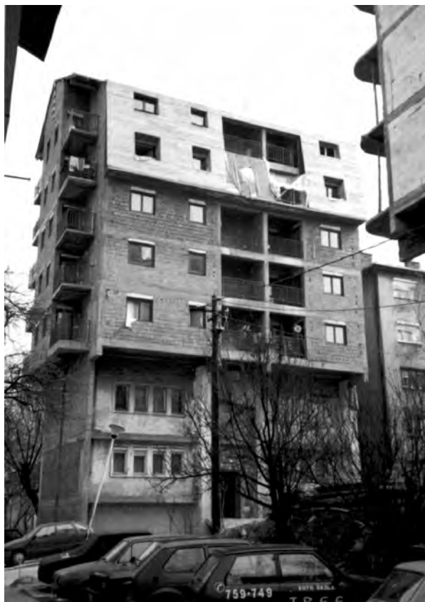
Sl.22 – Jedan od više objekata P+1 u Sretničkoj ul. na Karaburmi, koji su nadgradjeni sa pet i po novih etaža, uz bezobrazno izlaženje dodatnih spratova izvan gradjevine linije po celoj širini objekta
