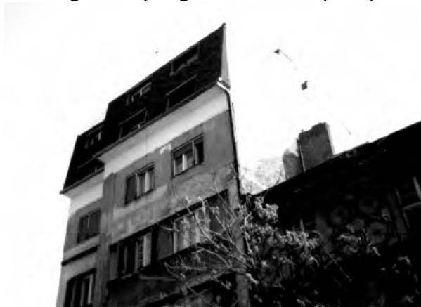
Sl.19 – Primer substandardne nadgradnje u Novopazarskoj ul. koja svojim nekvalitetom degradira ceo objekat.
