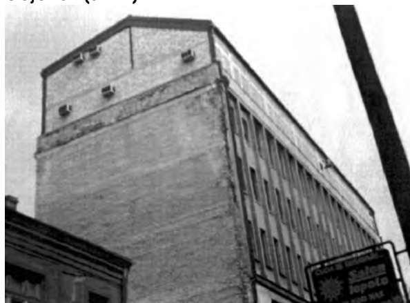
Sl.13 – Primer substandardne nadgradnje.
