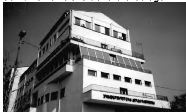
Sl.2 – Necivilizovani krpež iznad Dečje klinike u Tiršovoj ul. u Beogradu. Ova zgrada, čiji je autor Prof. M. Zloković, je smatrana jednim od najlepših primera zdravstvenih objekata rane Moderne u Evropi.
