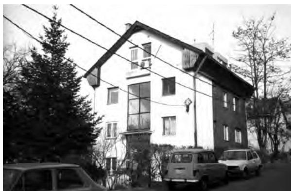
Sl. 4 – Nadgradnja stambenog objekta u ul. Zmaj Ognjenog Vuka u Beogradu. Primer vertikalnog proširenja dva stana na drugom spratu.
