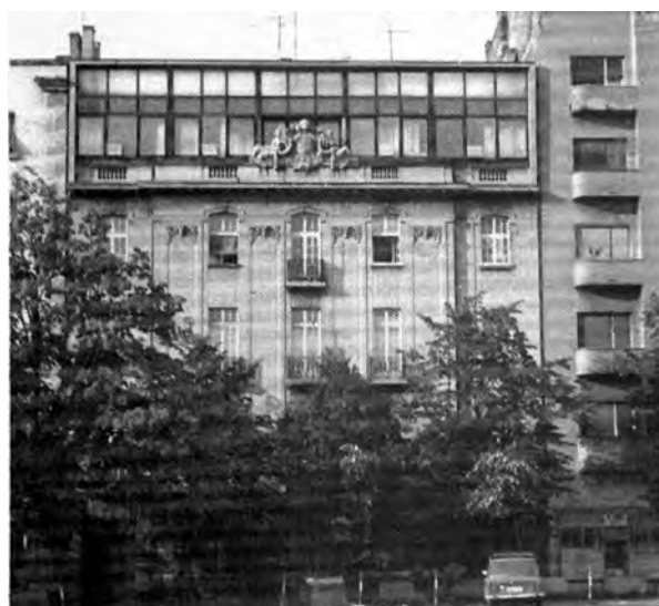
Sl.1 – Nadgradnja stambeno-poslovnog objekta u Njegoševoj ul. u Beogradu (M.Mitić i/ili L.Lenarčić)
