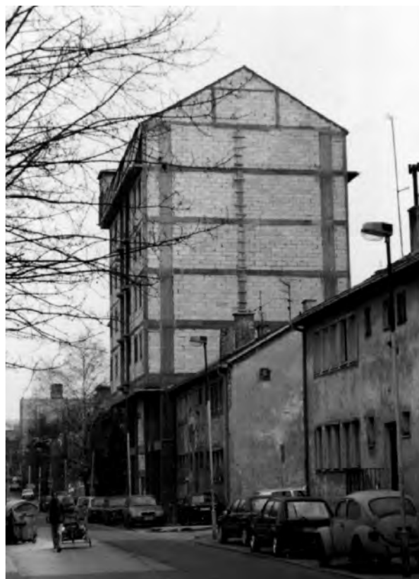
Sl.16 – Apsolutni rekord: 5 i po nadgradjenih etaža iznad skromnih kućica P+1 u Srnetičkoj ul. na Karaburmi. Ako i pretpostavimo da su svi imperativi vezani za bezbednost zadovoljeni ( a verovatno nisu), ostaje činjenica da je broj donaćinstava UČETVOROSTRUČEN, što dovodi do potpunog poremećaja svih urbanističkih parametara.
